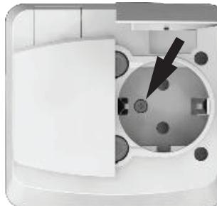
2. Poista pistorasian kanssi irrottamalla kannesta läppien alla olevat kaksi ruuvia. Kytke pistorasia kytkentäohjeen mukaan.
